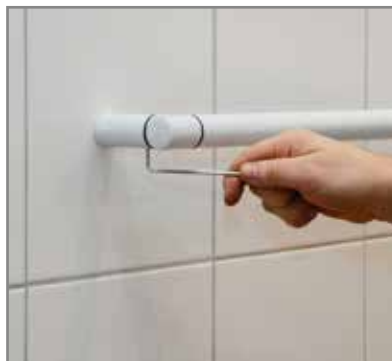
Gewindestifte eindrehen und anziehen.
