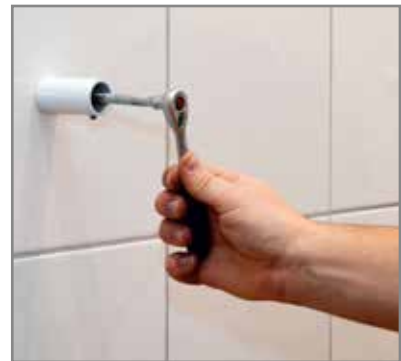
Zweites Anschlussstück montieren und ausrichten.
