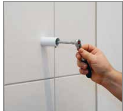
Anschlussstück an der Wand montieren.
